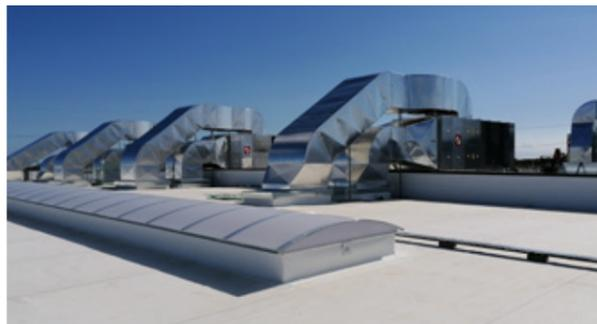
L'aria condizionata sia per il riscaldamento invernale che per il raffreddamento estivo è a servizio dell'area uffici, mentre l'area magazzino è servita solo dal riscaldamento invernale. La riduzione dei carichi termici e il mantenimento del comfort sono ottenuti tramite un sistema di espansione diretta ad alta efficienza con volume di refrigerante variabile.
